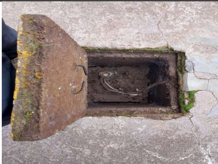
Fig. N° 09 POZO TIERRA NUMERO 02, UBICADO EN LA PARTE FRONTAL DELANTE DE LA OFICINA PRINCIPAL, PRESENTA CAJA DE CONCENTRO CON TAPA PINTADO DE COLOR AMARILLO
