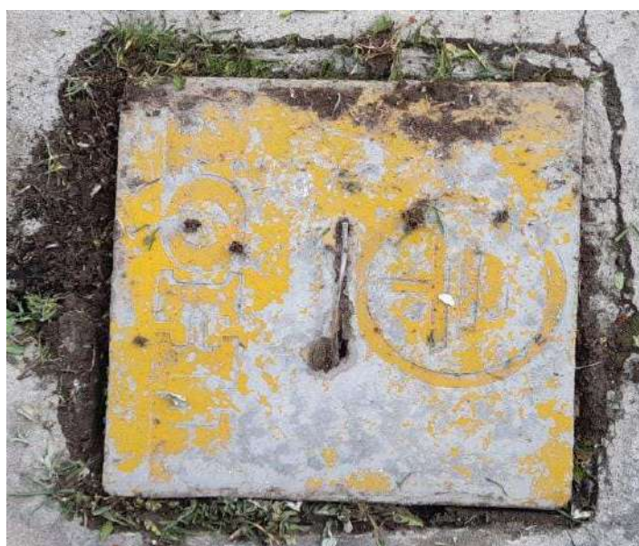
Fig. N° 24 UBICADO EN LA PARTE CENTRAL DEL PATIO, TAPA DESPINTADO, CON MARCOS DETERIORADOS
