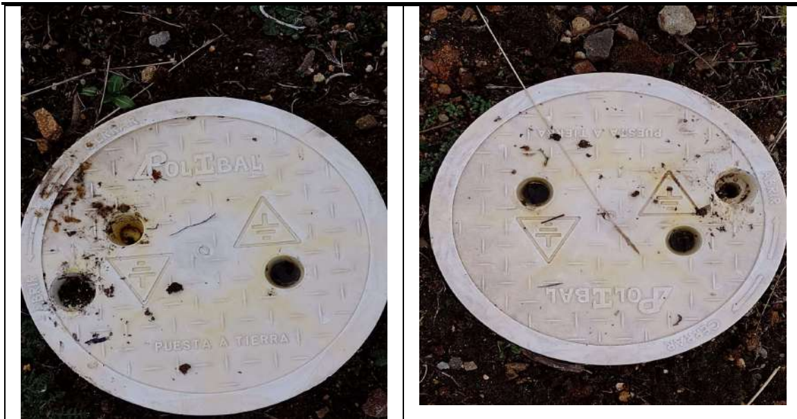
Fig. N° 19 POZOS UBICADOS ALREDEDOR DEL TAMBO, PARA CAMBIO DE CONECTOR Y LIMPIEZA.
