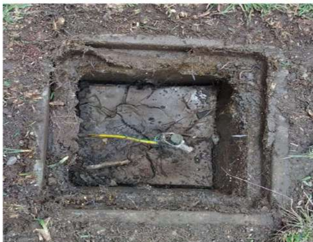
Fig. N° 29 UBICADO EN LA PARTE POSTERIOR, COSTADO IZQUIERDO, PRESENTA CAJA DE CONCENTRO DETERIORADO,. (pozo a intervenir).
