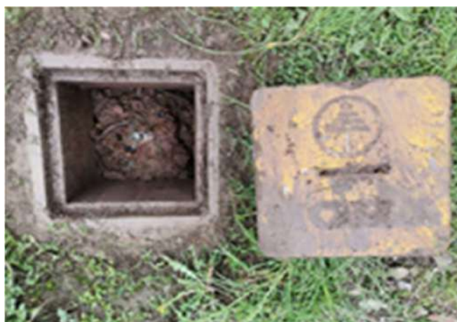
Fig. N° 22 UBICADO EN LA PARTE FRONTAL AL LATERAL DERECHO, PRESENTA CAJA CONCRETO CON TAPA DETERIORADA, COBRE PRESENTA SULFATACION. (pozo a intervenir).
