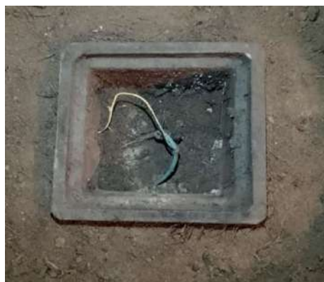
Fig. N°31 SE ENCUENTRA EN LA PARTE POSTERIOR DEL TAMBOS, LOS CABLES SE ENCUENTRAN SULFATADO. (pozo a intervenir).
