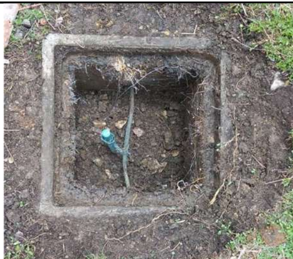
Fig. N° 30 UBICADO EN LA PARTE POSTERIOR, COSTADO DERECHO, PARA CAMBIO DE CONECTOR, TAPA Y LIMPIEZA
