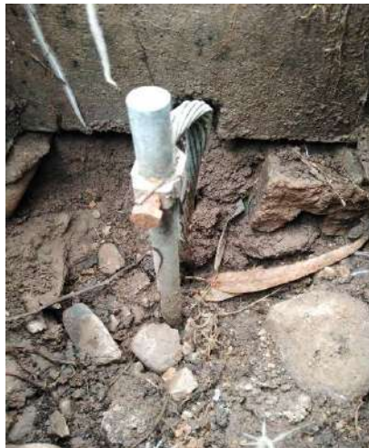
Fig. N° 12 UBICADO EN LA PARTE POSTERIOR, PRESENTA SULFATACION, (pozo a intervenir).
