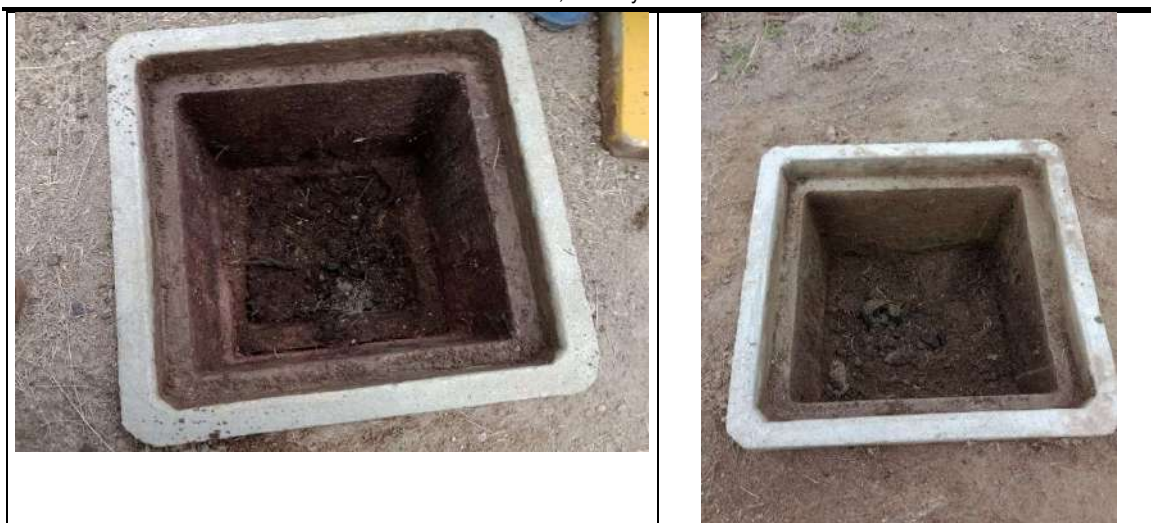
Fig. N° 21 POZOS UBICADOS ALREDEDOR DEL TAMBO, PARA CAMBIO DE CONECTOR, TAPA Y LIMPIEZA.
