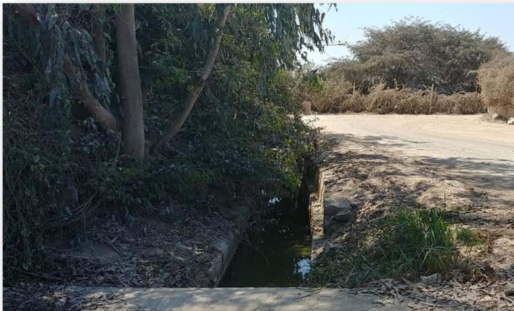
Imagen N.º 02 En la Fotografía se aprecia el canal que tiende a desbordarse en épocas de lluvia y tiende a deteriorar el borde la vía.
