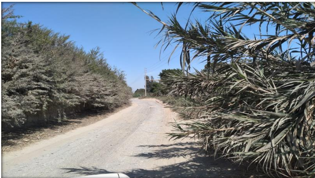
Imagen N.° 05 Se aprecia presencia de vegetación en ambos lados de la pista, así mismo la división del limo y la grava producto de las lluvias.
