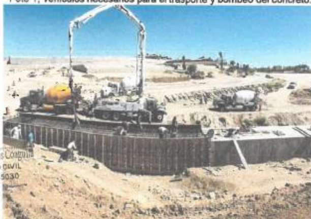
Foto 2; vehículos necesarios para el transporte y bombeo del concreto.
