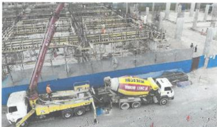
Foto 1; vehículos necesarios para el transporte y bombeo del concreto.
