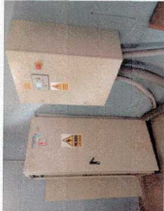
BAYA TENSION - CASA DE FUERZA: - TABLERO GENERAL AUTOMATIZADO 220V - (TRIFASICO, 60HZ) - TABLERO DE TRANSFORMACION AUTOMATICA (AUTOCORRIENTE, TTA 220V/60V/12) - GRUPO ELECTROGENO (ABIERTO, 70KW PRIME, 220V, TRIFASICO, 60HZ)
