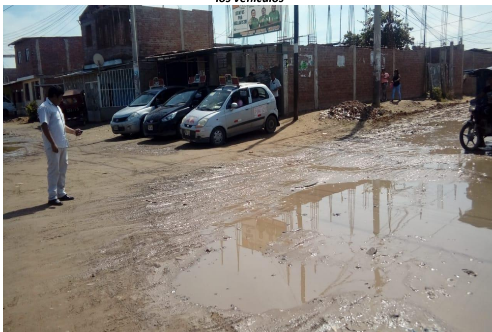
Interseccion de Av. Brasil con Calle el Condor, la superficie de rodadura es de terreno natural, viéndose afectada por las intensas lluvias y formándose aniegos en la misma, dificultando el tránsito de los vehículos
