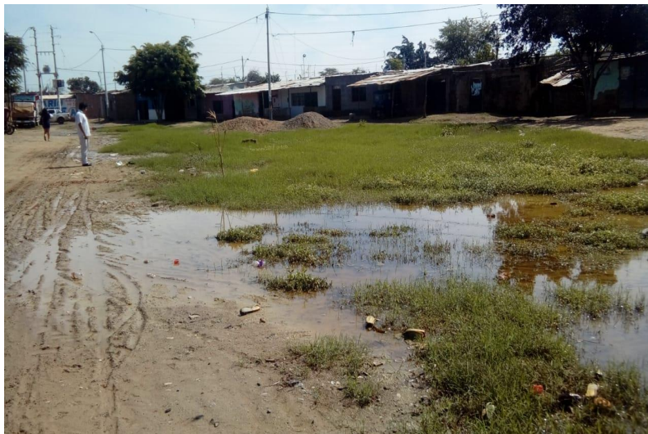
Calle General Garzon, la superficie de rodadura es de terreno natural, viéndose afectada por las intensas lluvias y formándose aniegos en la misma, además de crecimiento de vegetación que dificulta el tránsito de los vehículos
