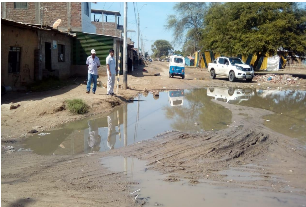
Interseccion de Av. Brasil con Calle Victor Raul Haya de la Torre, la superficie de rodadura es de terreno natural, viéndose afectada por las intensas lluvias y formándose aniegos en la misma, dificultando el tránsito de los vehículos.
