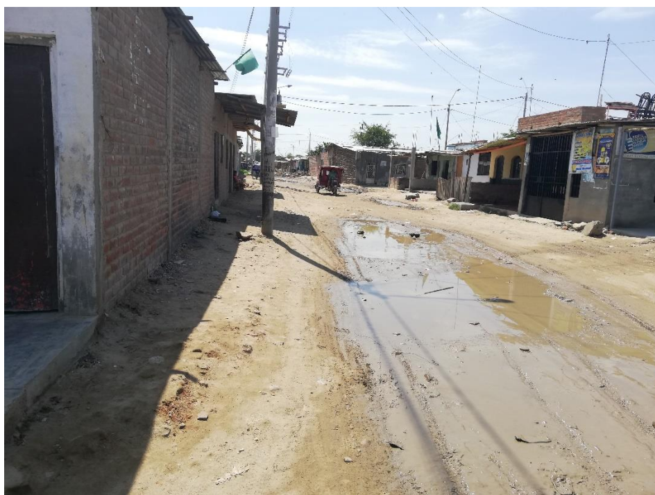
Interseccion de Av. Brasil con Calle Victor Raul Haya de la Torre, la superficie de rodadura es de terreno natural, viéndose afectada por las intensas lluvias y formándose aniegos en la misma, dificultando el tránsito de los vehículos.
