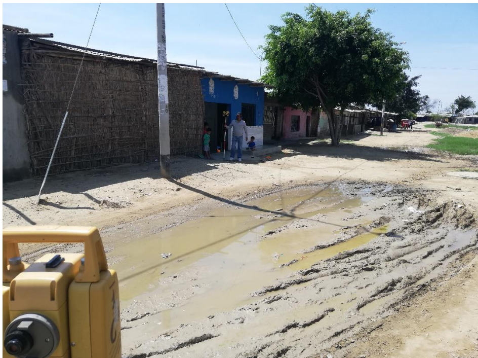
Calle Miguel Grau, la superficie de rodadura es de terreno natural, viéndose afectada por las intensas lluvias y formándose aniegos en la misma, dificultando el tránsito de los vehículos.
