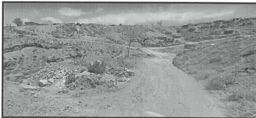
Situación actual de la vía en el límite de los distritos de Cerro Colorado y Cayma, en donde se observa la ausencia de pavimento
