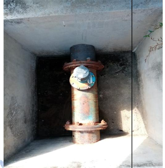
Vista donde se instalara los display de los caudalímetros el armario sé que se aprecia se retirara, señalándose que la distancia entre los equipos caudalímetros y el punto donde serán instalados los display tiene una longitud/ distancia de 15m.
